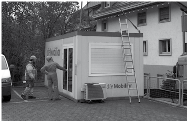
Das Provisorium hinter der Generalagentur an der Kasernenstrasse 11 in Bülach.
