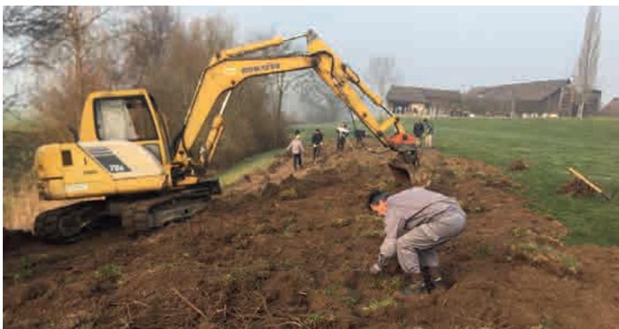
Arbeit am Bord: der Trax löst die oberste Erdschicht. Die Wurzeln werden von Hand aussortiert.
